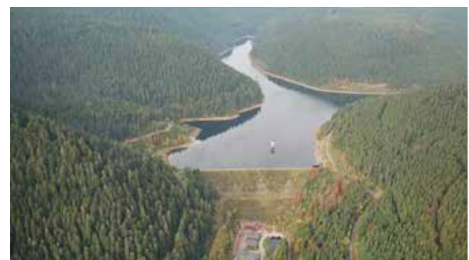
Talsperre Kleine Kinzig mit Maschinenhalle und Wasserwerk (Bild: Wolfgang Strasser)
